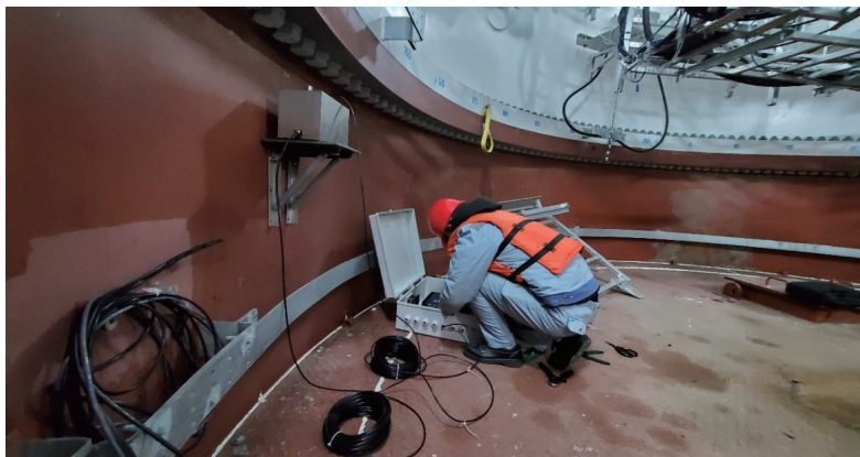
图 5-1 安装调试“机器振动监测系统”
